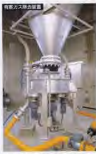
焼却炉に送られる有機ガスなどを活性炭により吸着除去して空気中に放出します。
