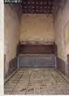
焼却炉の炉内は、炉内から燃焼したごみ、燃焼炉内を流して燃焼炉外へ排出されます。
