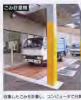
運送したごみを計量し、コンピュータで計量単位を日毎、月毎などを記録作成します。
