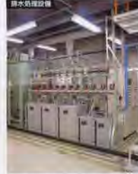
工場内で排出される排水は、排水処理設備で処理後、下水道へ排水として供給されます。排水は工場内に回収されます。
