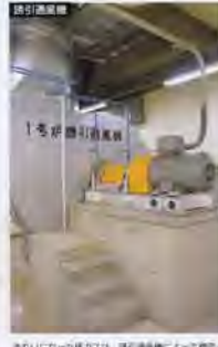
きれいな空気は、誘引通風機によって燃焼炉の大気へ吸引されます。
