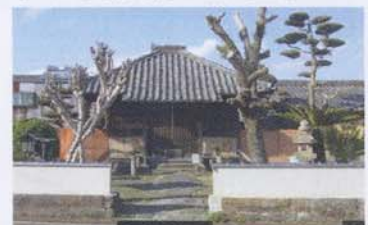
④大福院本堂【現状写真】
